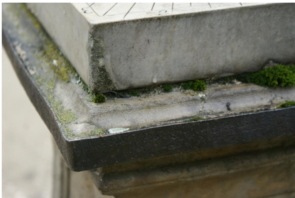
5. Skorodowana żelazna opaska.
