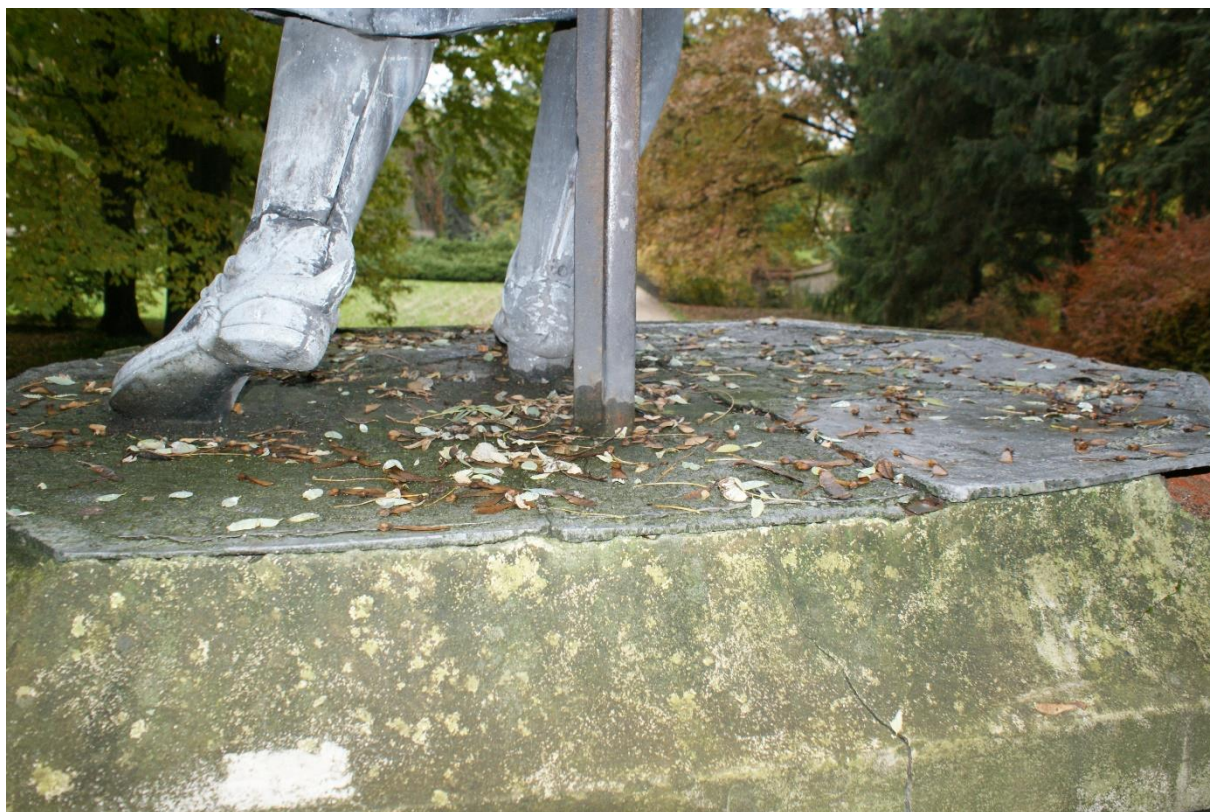
8. Mocowanie na stalowej płycie.
