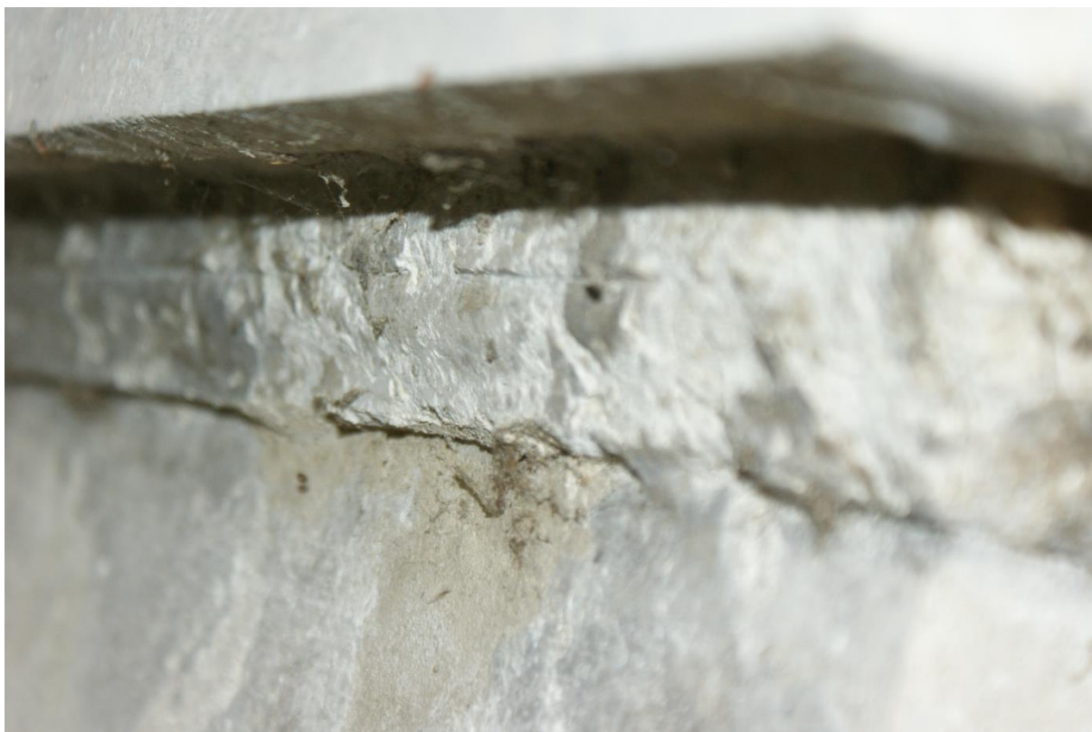
6. Widoczne ubytki w listwie pod górnym cokołem.
