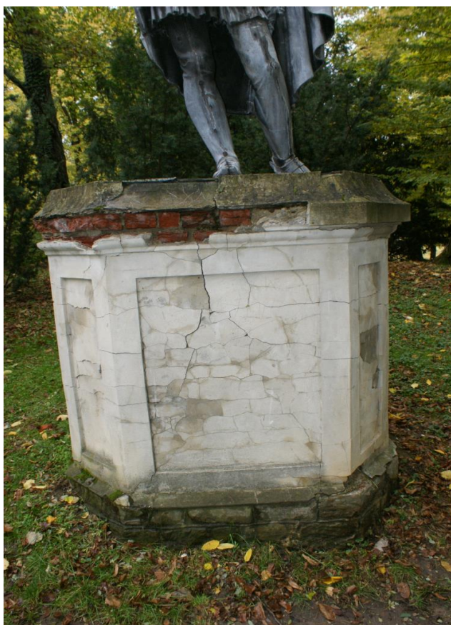
6. Zniszczenia tynkowanego postumentu
