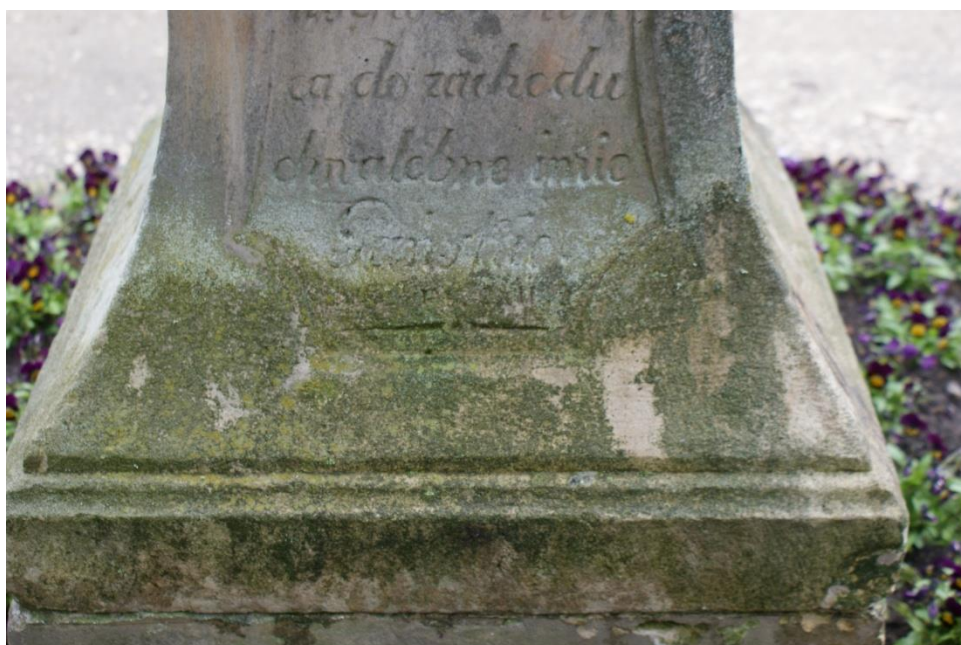
3. Widoczne zagryzienie w dolnej części podstawy zegara.
