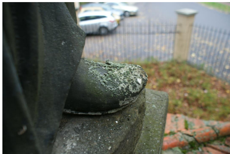
5. Zbliżenie stopy, widoczne porażenie biologiczne
