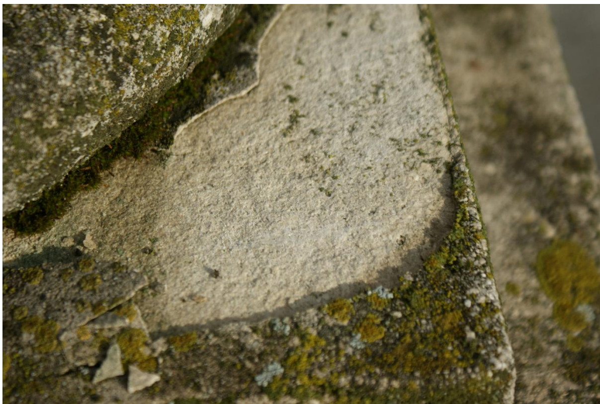
6. Całkowite zwietrzenie kamienia wierzchniej warstwy podstawy pod kolumna.
