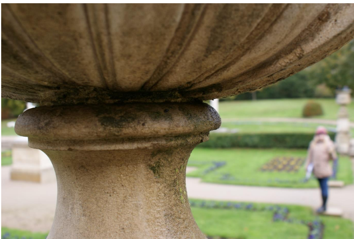
3. Zaciemnienie w miejscu łączenia
