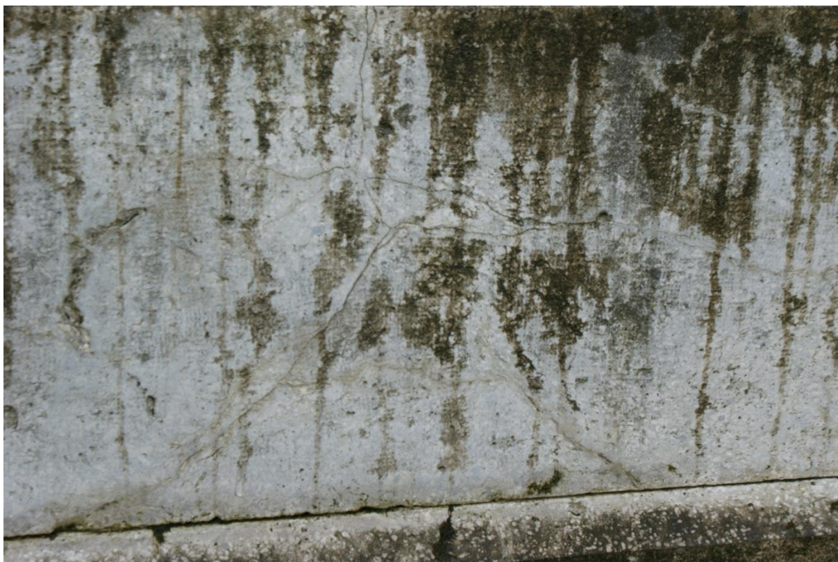
8. Widoczne zagrzybienia i spękania na tylnej części postumentu od strony ujeżdżalni.
