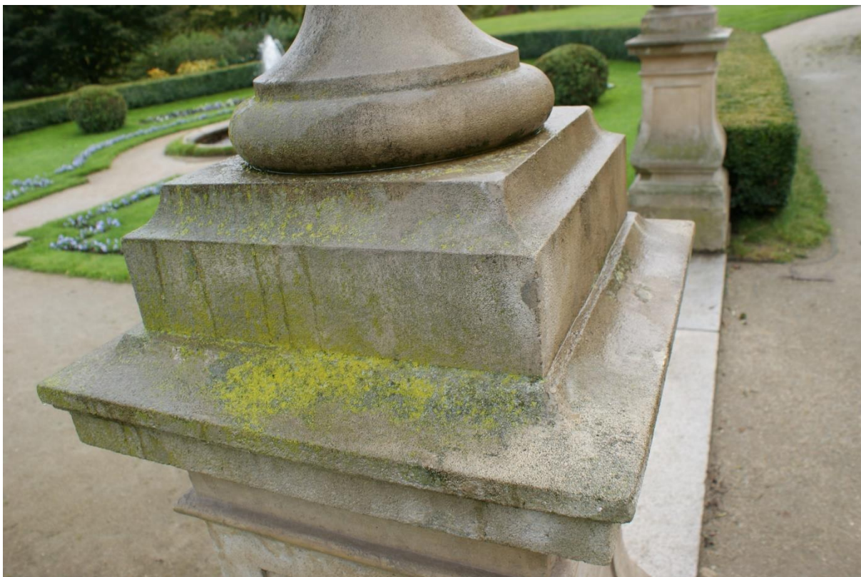
2. Nalot mikrobiologiczny na podstawie jednej z waz
