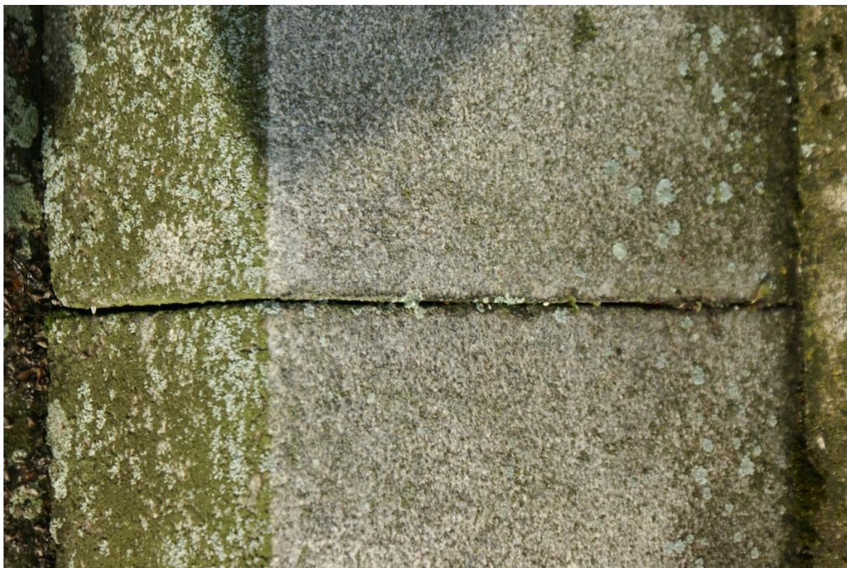
7. Rozspojenie połączeń na podstawie postumentu.
