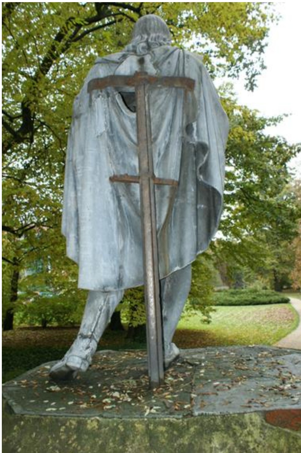
2. Widok na odwrocie posągu, widoczna stalowa konstrukcja nośna
