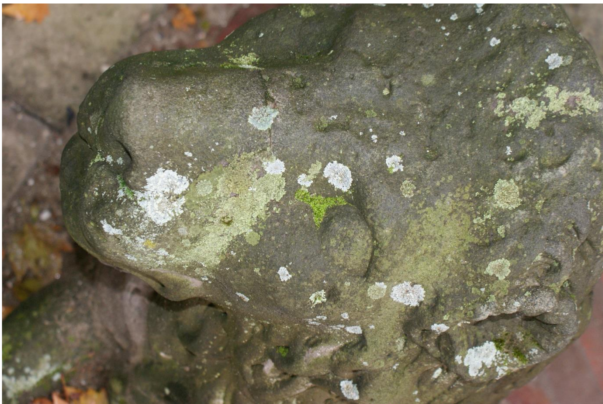
3. Zbliżenie głowy lwa, widoczne ogniska porażenia grzybami i mchami
