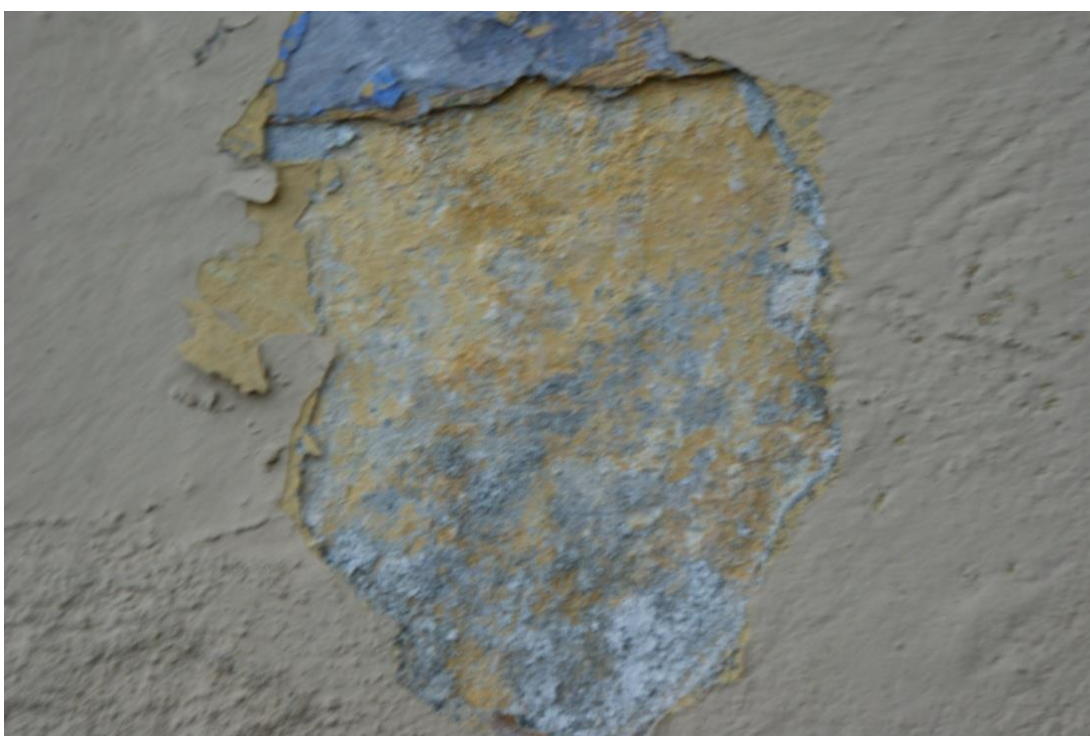
8. Odkrywka ściany kapliczki – wiele wtórnych nawarstwień bez wyraźnych powłok oryginalnych
