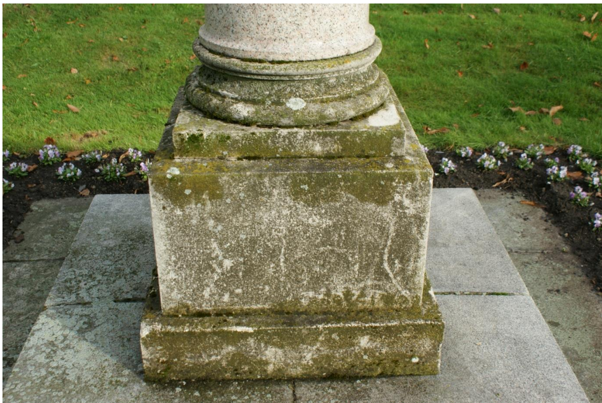
5. Widoczne porażenie mikrobiologiczne na postumencie pod Orłem.
