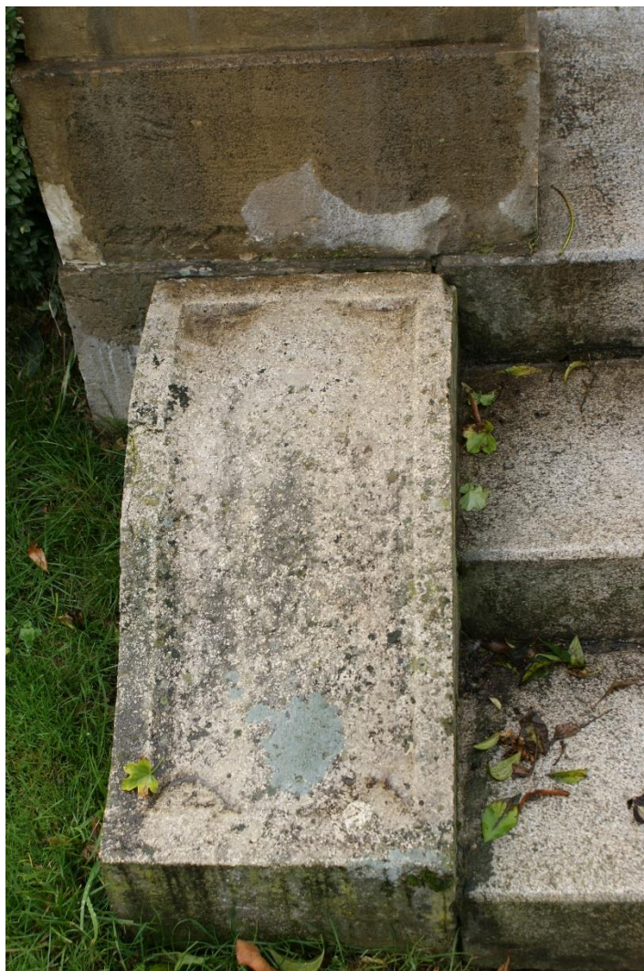
4. Zawilgocenie cokołu, uszkodzenia balustradki schodów
